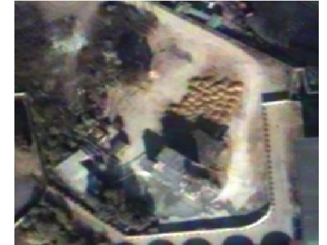
Скопления грунта, строительные материалы
